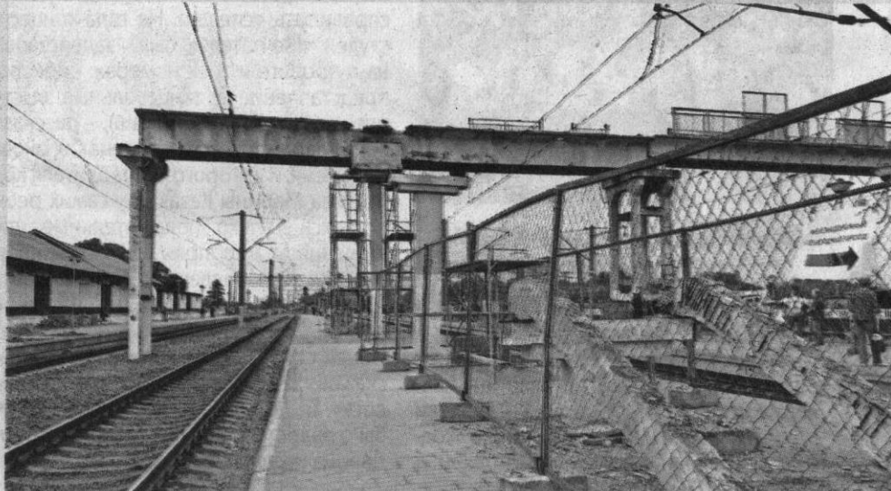
Демонтаж пешеходного моста начат 20 мая
