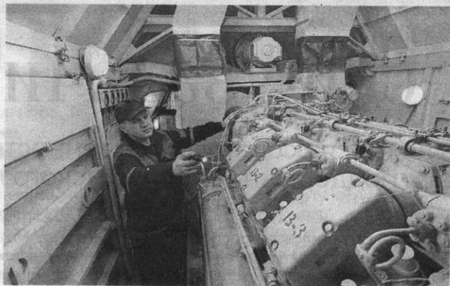
Во время ремонта тепловоза
