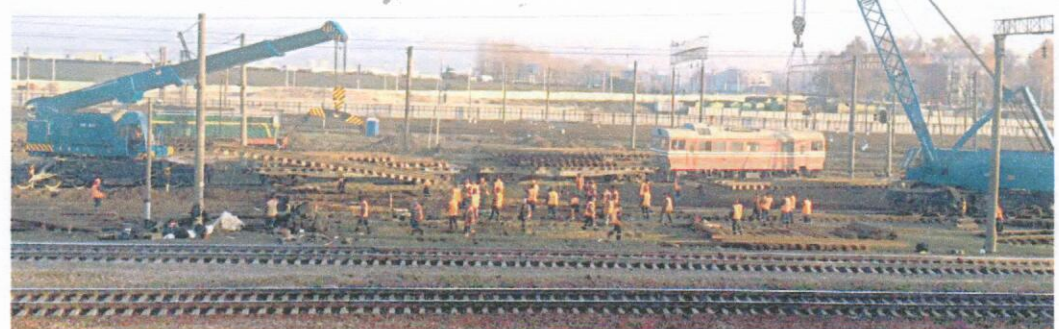
Комплексное «окно» по замене стрелочного перевода и глухого пересечения.
