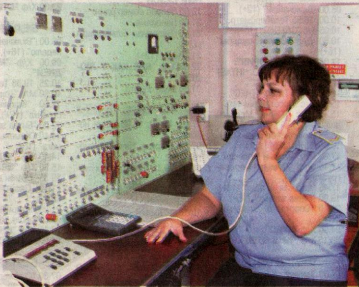
Дежурный по железнодорожной станции Наталья Альховка умело управляет движением с пульта электрической централизации. ФОТО НАТАЛЬИ СТУКАЛОВОЙ
